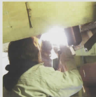
電気溶接作業
